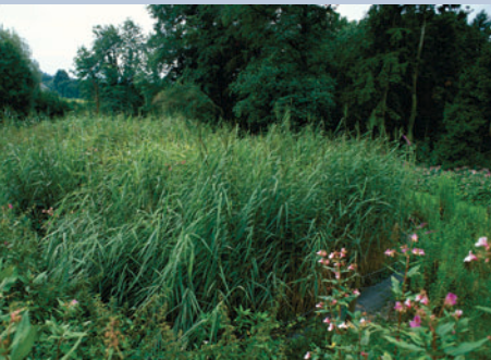
Εγκατεστημένοι κατασκευασμένοι υγρότοποι
