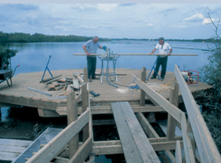
Κατασκευή του Σανιδοδιαδρόμου στα Μπράντς
