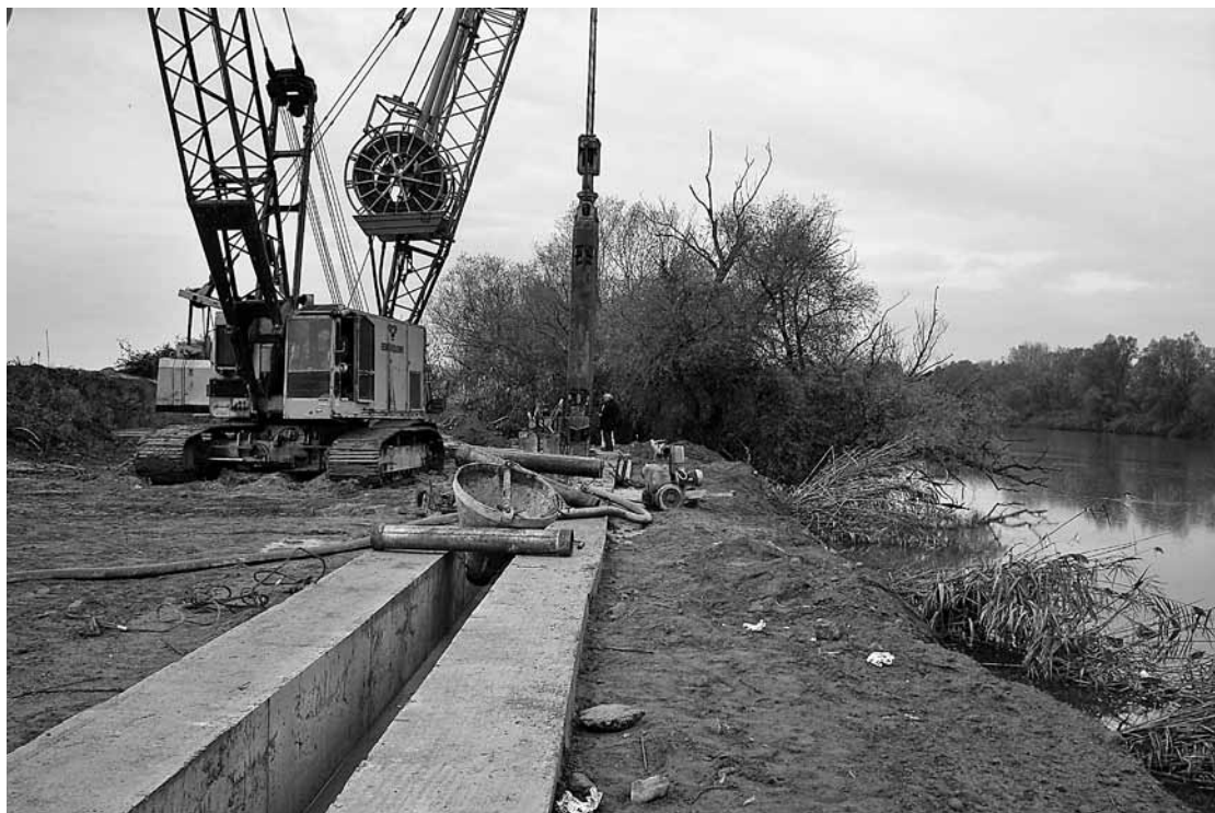
Θεμελίωση αρδευτικού φράγματος (π. Αξιός).
