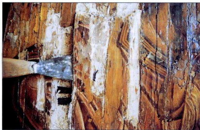
4. Η ζωγραφική επιφάνεια (περιοχή προσώπων) μετά την αφαίρεση των φύλλων καπλάμα, που είχαν τοποθετηθεί σε φάση παλαιότερης συντήρησης.
