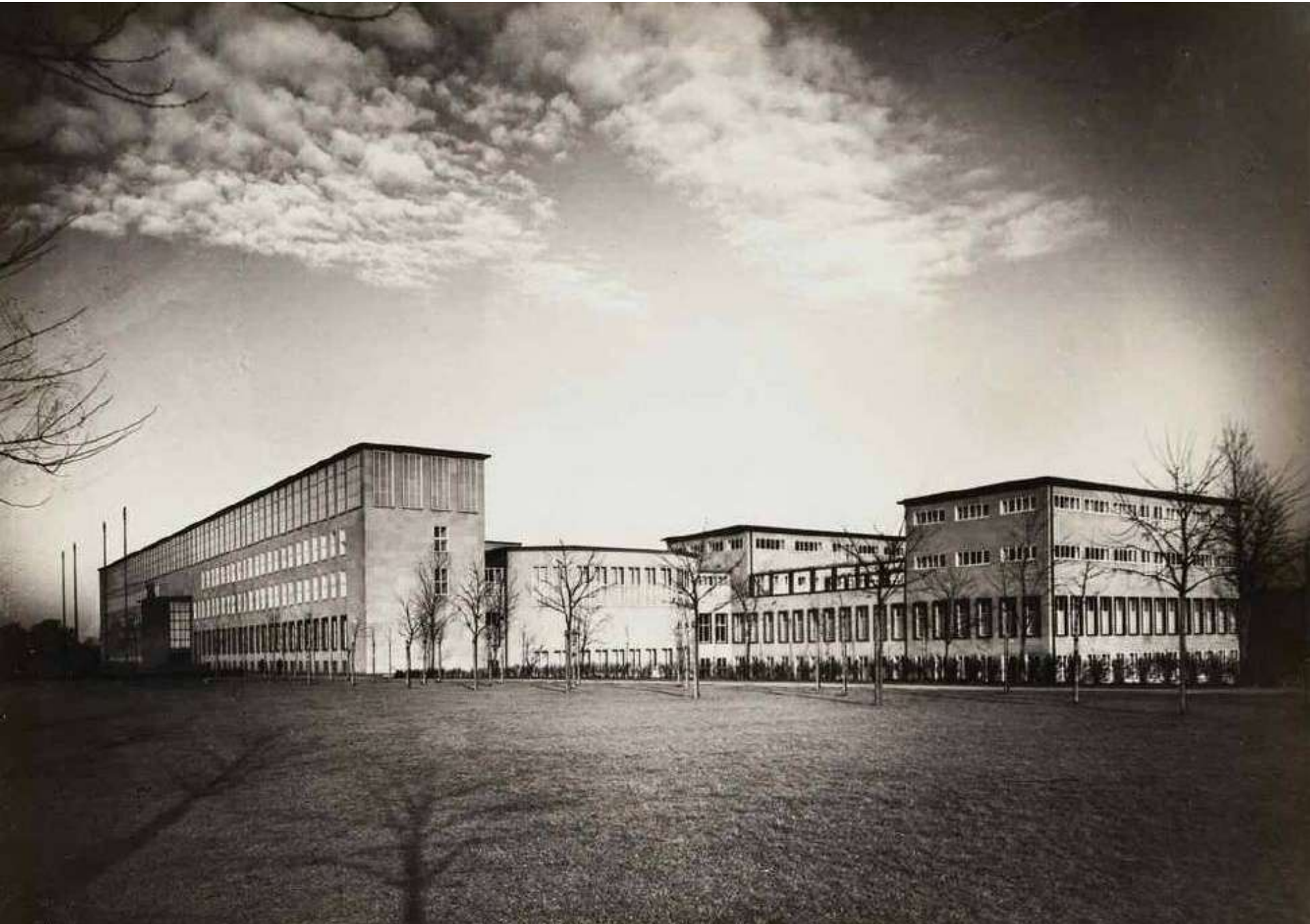
August Sander, Πανεπιστημιακά Κτίρια, Κολωνία 1935-37
