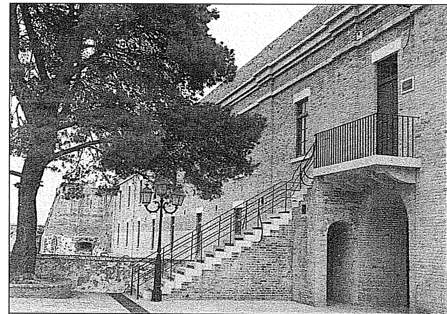
Το κτίριο των Αρχείων του Νομού Κέρκυρας. Παλαιό Φρούριο Κέρκυρας.
