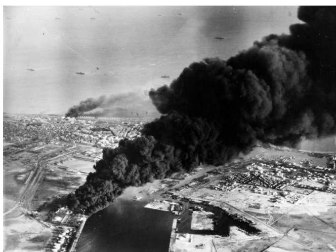
Εικόνα 6.4 Δεξαμενές πετρελαίου δίπλα στη διώρυγα του Σουέζ έχουν πάρει φωτιά κατά τη βρετανογαλλική επίθεση στο Πορτ Σάιντ, στις 5 Νοεμβρίου 1956.
