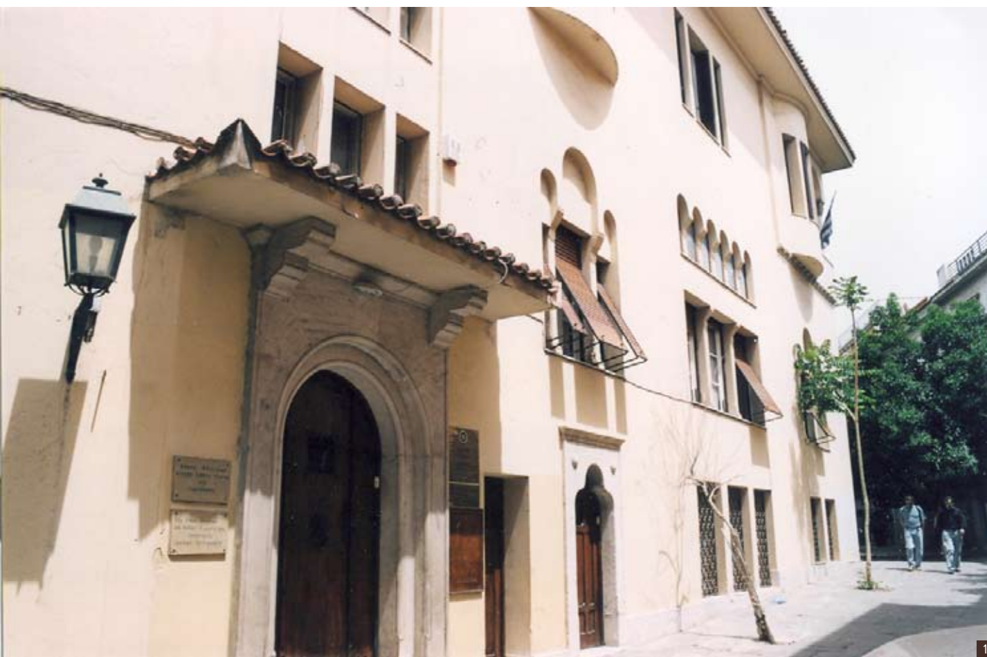
1 Εικ. 1: Όψη της Οικίας Χατζημιάλη στην Πλάκα.
