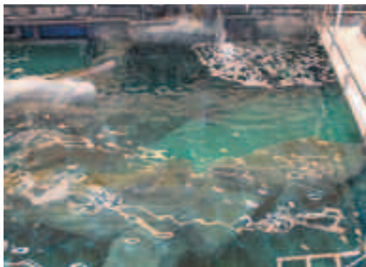
Άποψη δεξαμενής από το δώμα του κτιρίου με τις βοηθητικές εγκαταστάσεις
