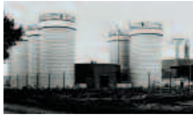
Σχήμα 5. Αναερόβιος αντιδραστήρας σταθερής κλίσης πλήρους κλίμακας στη βιομηχανία αμύλου
