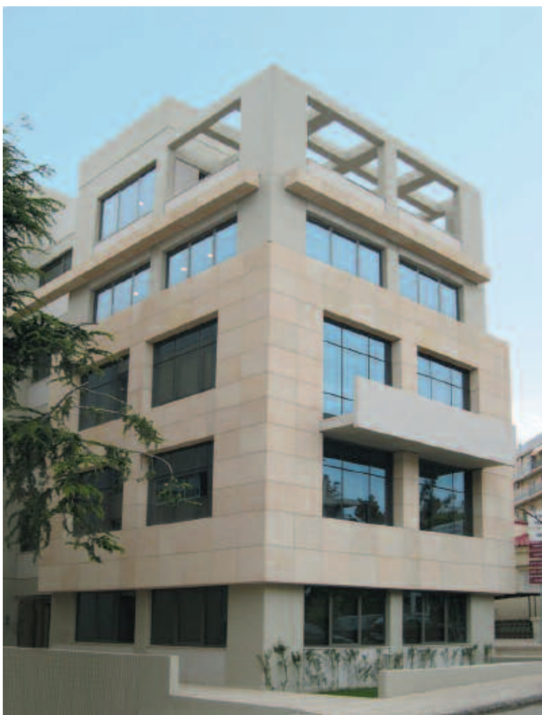
Το κτίριο Διοίκησης παραπλεύρως του μαιευτηρίου ΛΗΤΩ
