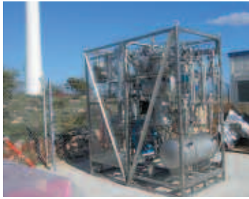
Τοποθέτηση μονάδας ηλεκτρόλυσης
