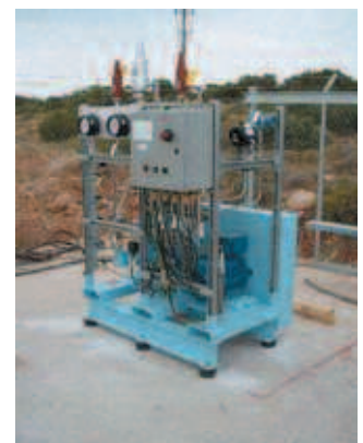
Τοποθέτηση μονάδας συμπιεστή
