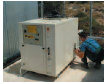
Εγκατάσταση περιφερειακών συστημάτων: Μονάδα ψύξης νερού και συμπιεστής αέρα
