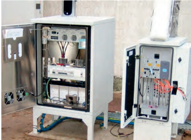
Εικόνα 198. Εξοπλισμός βάσης δικτύων τέταρτης γενιάς 4G. By Groupe Aménagement Numérique des Territoires, https://upload.wikimedia.org/wikipedia/commons/d/d2/WiMAX_equipment.jpg
