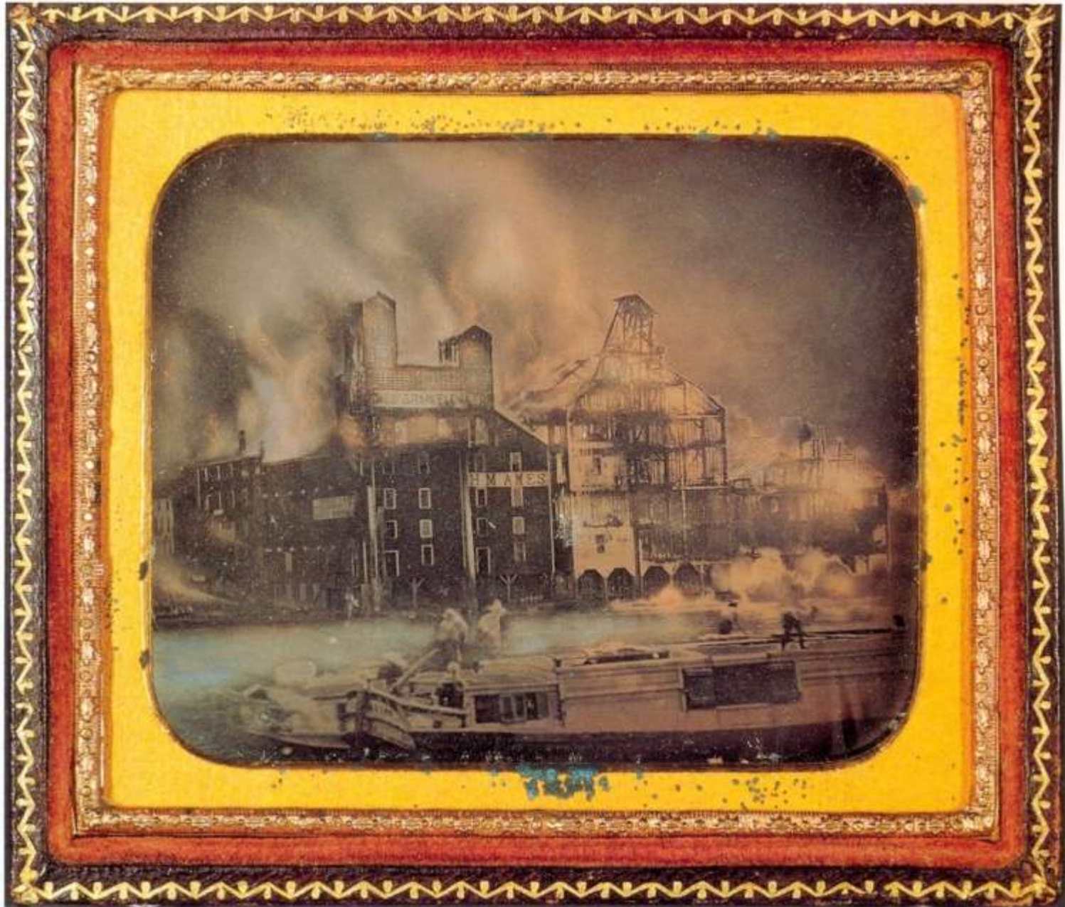
George Barnard, Πυρκαγιά εργοστασίου, Oswego, Νέα Υόρκη, 1853
